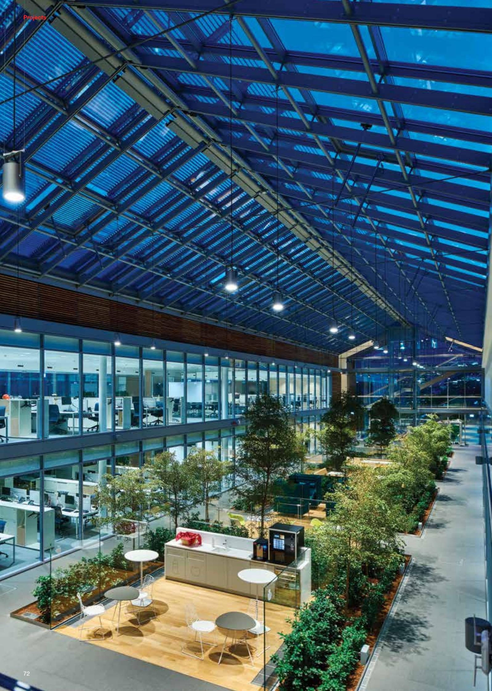
Tre corpi di fabbrica intervallati da due “Serre”, spazi vetrati caratterizzati dalla presenza di vegetazione di tipo idroponico che nel complesso contribuiscono alla regolazione del microclima.
